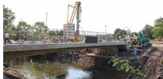
aufgeladen und abtransportiert
