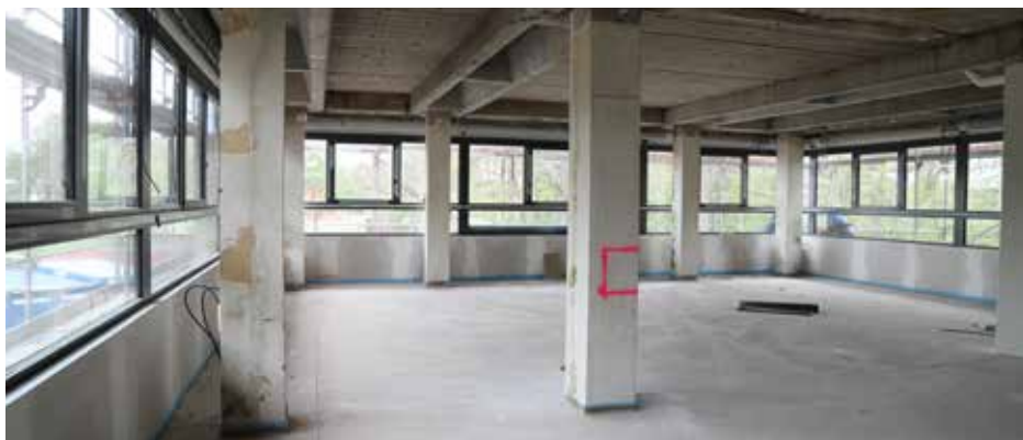
Die neuen Räume entstehen
